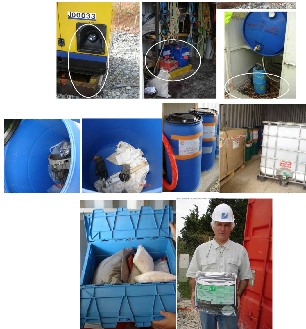
Illustration 245 : Bac de stockages de produits chimiques (Source photo : CETE)
