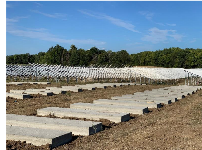
Illustration 231 : Photographie de fondations de longrines sur le site de Mer (41)
