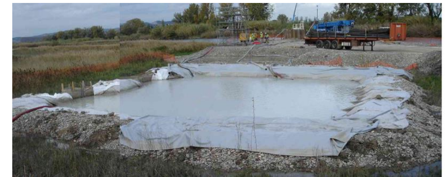
Illustration 244 : Bassin provisoire de décantation des MES et autres polluants (Source photo : ADEV Environnement)
