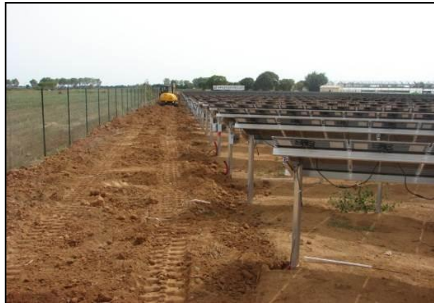
Illustration 235 : Récouvrement des tranchées
