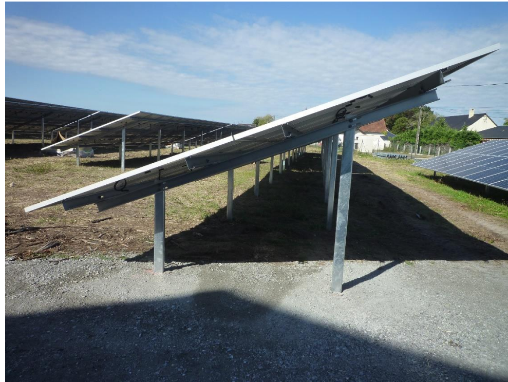
Illustration 229 : Exemple de pieux battus (Source : EREA Ingénierie)
